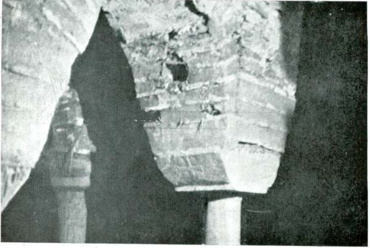
Res. 27 — Merkezi binanın altındaki sarnıç. Fig. 27 — The cistern under the building.
