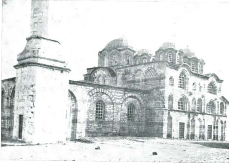
Res. 24 — Paraklesiyonun fasadını süsleyen arkatürler ve minare ile bina arasındaki taşıyıcı kemerler. Fig. 24 — A general view of the church.
