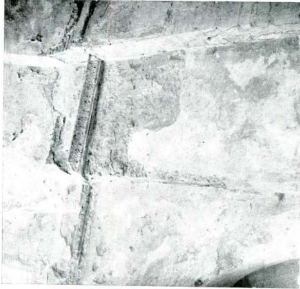
Res. 11 — Duvar ve Kemer başlangıçlarındaki mermer silme kalıntıları. Fig. 11 — Remnant of marble mouldings on the walls.
