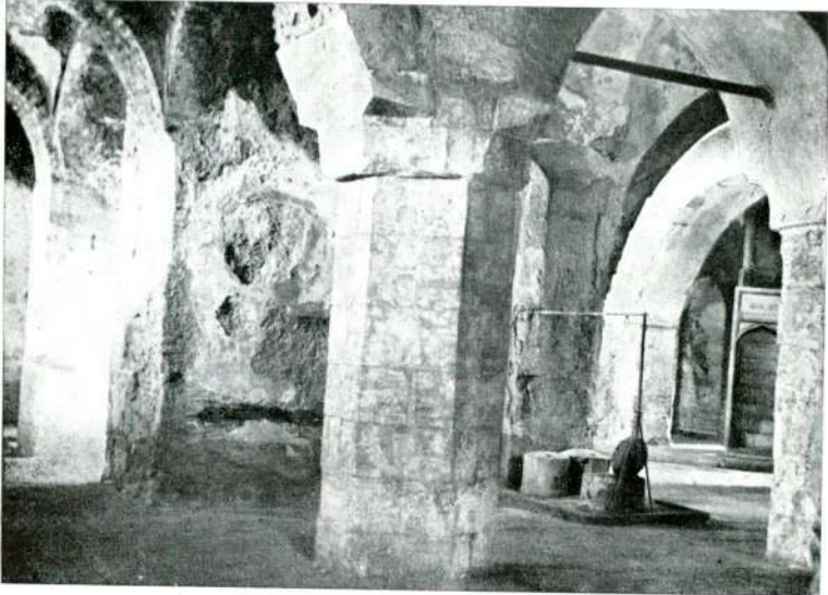
Res. 8 — Galeri ve nartekslerdeki bodur ve kalın sütun ve pilpayeler. Fig. 8 — Massive piers in gallery and narthex.
