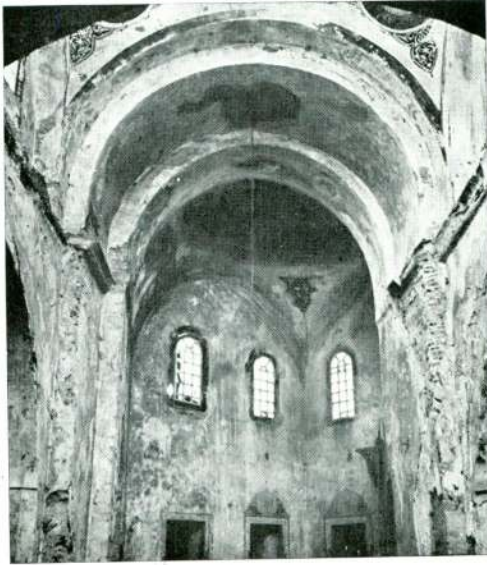
Res. 10 — Merkezi kubbenin bastığı doğu kemer. Fig. 10 — Eastern arch supporting the central dome.
