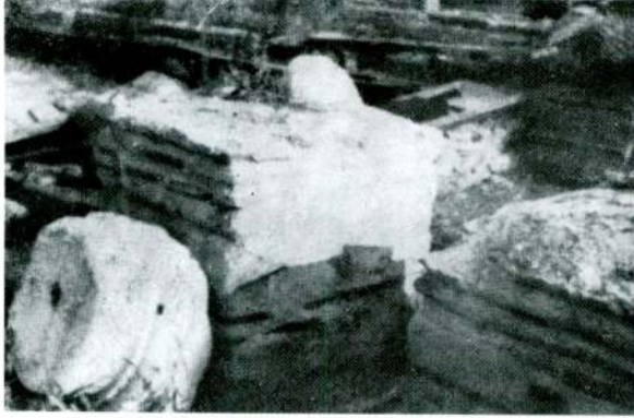
Res. 4 — Kilisenin iç duvarlarından biri (Önde sütun kaidelerinden biri görülmektedir).
