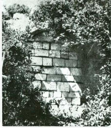
Res. 10 — Arabacı kapı civarındaki diğer Niş.
