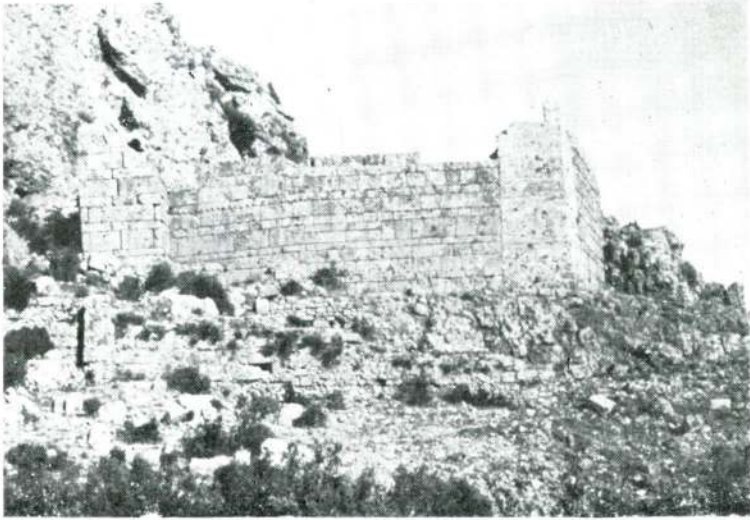
Res. 37 — Sillyon. İstinat duvarları ve tahkimat kalıntıları
