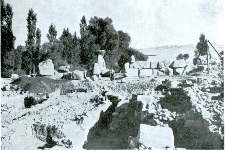
Orta Eti katında kanalizasyon Canalisation à l'étage hittite moyen
