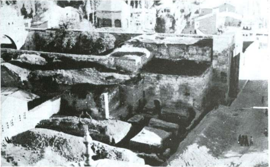
Kale camisi minaresinden (şimalden) sondaj sahasının görünüşü
