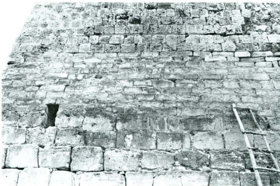
Abb. 4 — Van Kalesi. Die Zitadelle. Detailaufnahme der Bauschicht mit den beschrifteten Steinen.
