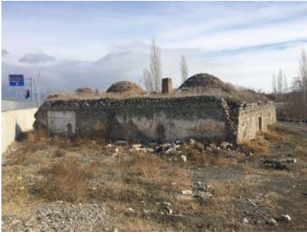
Foto 15. Nafiz Paşa hamamı kuzeybatı cephe.
