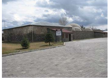
Foto 8. Çadırcı hamamı kubbe.
