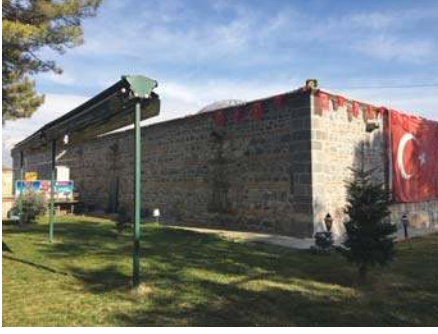
Foto 23. Taşçı hamamı batı cephe.
