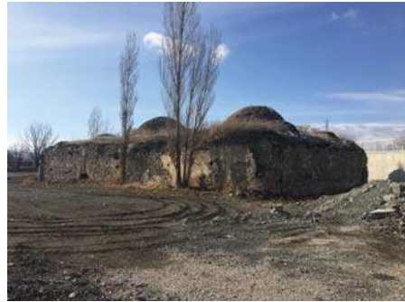
Foto 18. Nafiz Paşa hamamı kuzeydoğu cephe.
