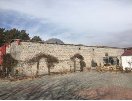
Foto 21. Taşçı hamamı dođu cephe
