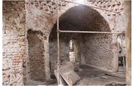
Foto 12. İzzet Paşa hamamı soğukluk (Erzincan Kültür ve Turizm Müdürlüğü).
