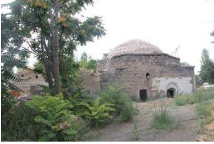
Foto 1. Çadırcı hamamı doğu cephe.
