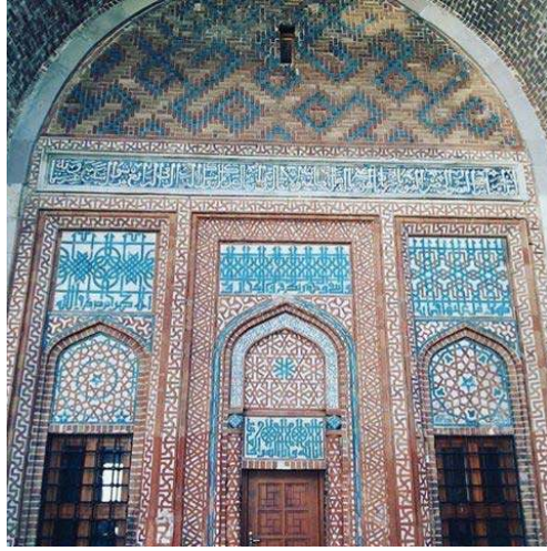
Fotoğraf 8. Sivas I. İzzeddin Keykavus Darüşşifası, kuzey cephe, kapı ve pencereler.
