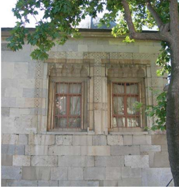
Fotoğraf 14. Çay Taş/Yusuf Bin Yakub Medresesi Türbesi, kuzey cephe, türbe pencereleri.
