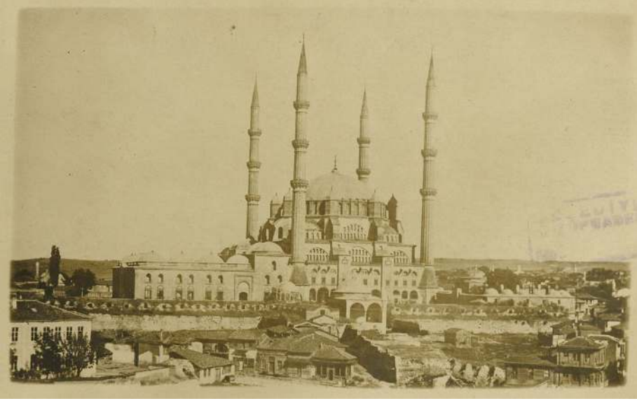
Resim 3: Selimiye Camii'nin batısındaki dükkân kalıntıları 56
