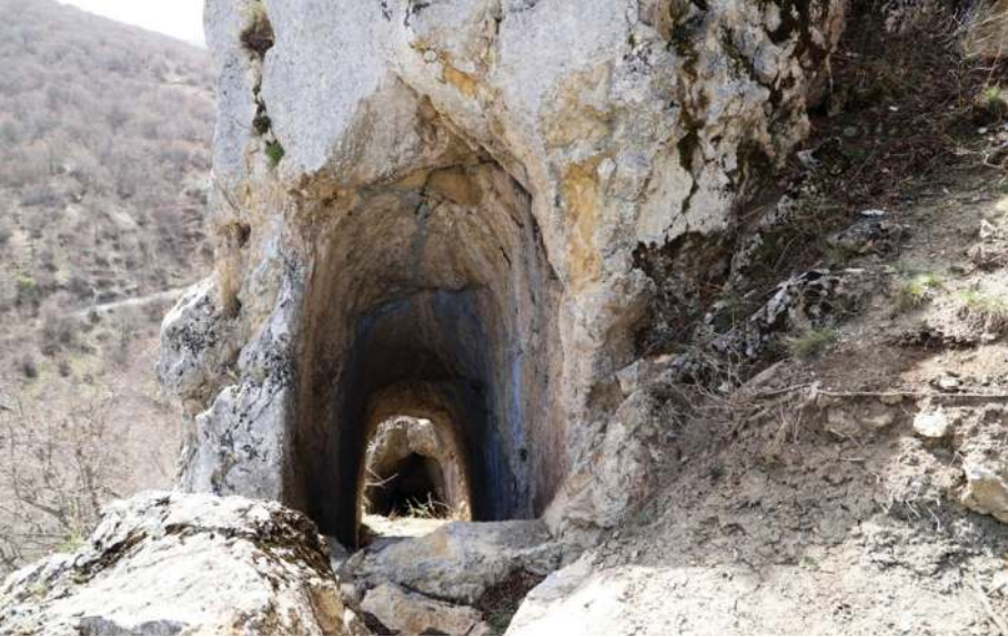
Resim 6: Dereköy Kalesi Basamaklı Tüneli (Dıştan Görünüm)
