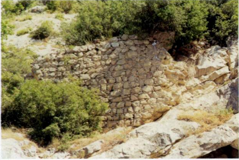
Res.3 - Kayalara oturtulmuş sur duvar kalıntıları, Asarkale.
