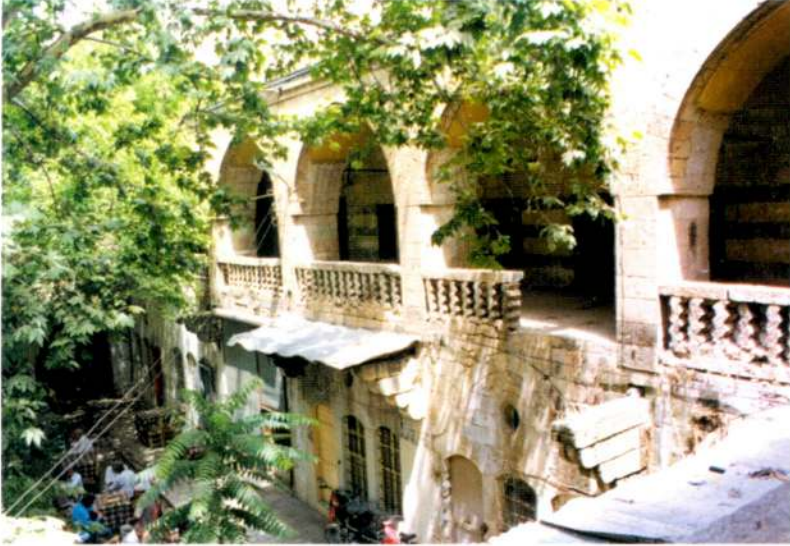
Res. 2 - Gümrük Hanı, avlu kuzey revakları.
