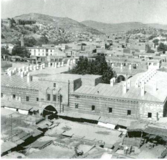
Res. 1 - Gümrük Hanı genel görünüm.
