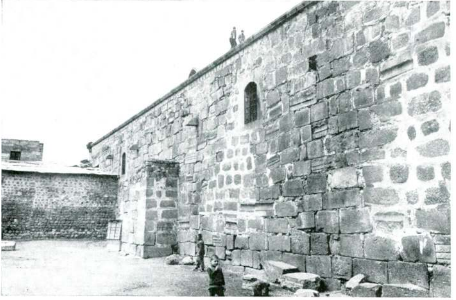
Resim 4 — Hacı Kılıç camisi mihrap duvarı.
