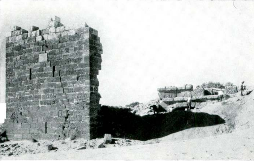
Res.12 — 12 no.lı kulenin doğu cephesi. Sağda geride kapı görülüyor.
