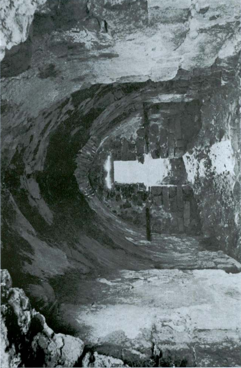
Resim 8 — Zemin Kat Salonunun Güneydoğuya Bakan Penceresi
