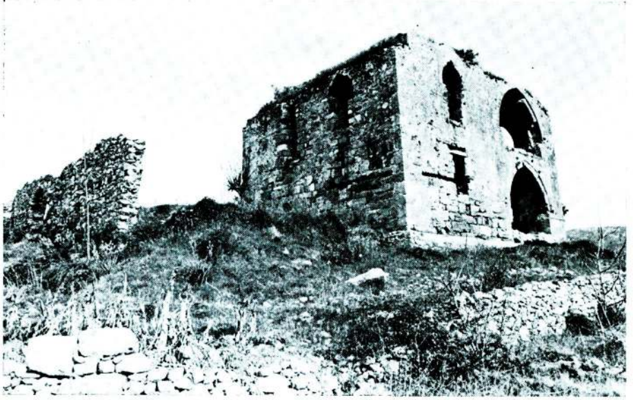
Resim 5 — Güneydoğu - Güneybatı Görünüşü ve Yan Bahçe Duvarı
