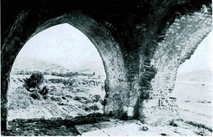
Resim 19 — Birinci Kat Balkonunun Genel Görünüşü
