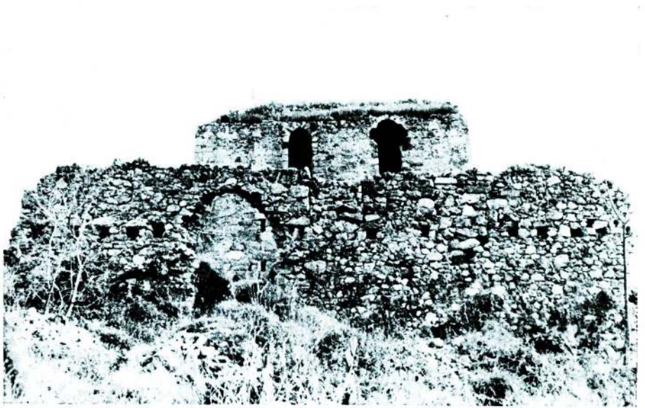
Resim 6 — Güneybatı'dan Yan Bahçe Duvarının Görünüşü
