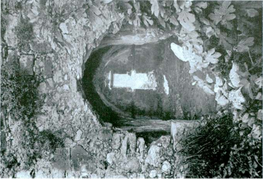
Resim 21 — Kuzey Batı Cephesindeki Ana Giriş Kapısı
