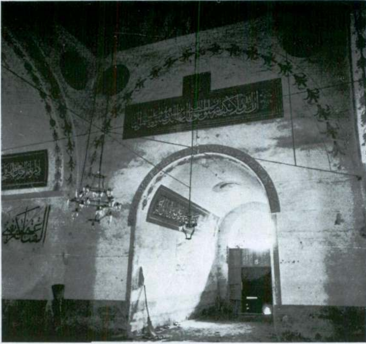
Res. 9 — İç Görünüş (Giriş eyvanı). Pl. 9 — Interior View (entrance eyvan).
