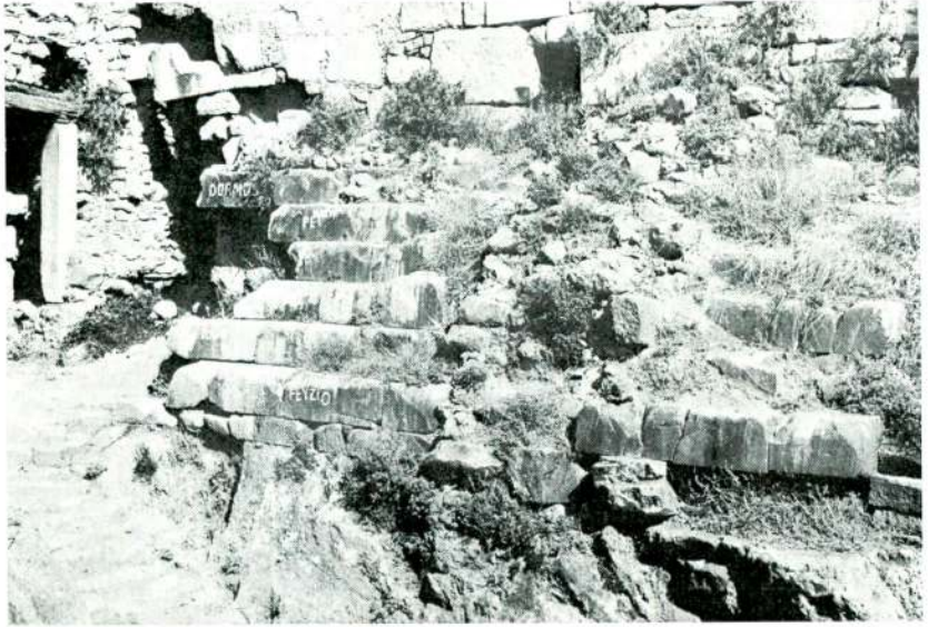
Beçin, tapınak basamakları üzerine oturan kapı tonozu temelleri
