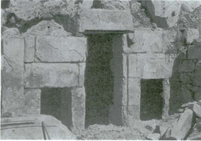
Res. 42 — Şapelin önündeki kapılı ve pencereli duvar
