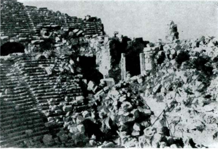
Res. 19 — Sahne binası cephesinin batı tarafı
