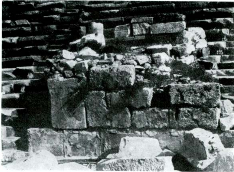
Res. 40 — Orkestra'nın etrafını çeviren geç devir duvarı
