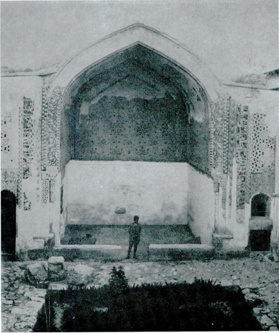
Res. 15 — Konya Sırçalı Medrese Eyvan cephesi.
