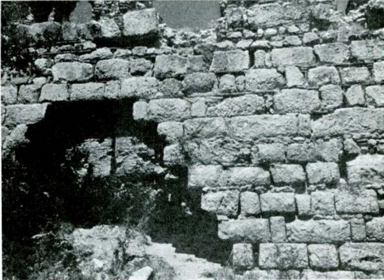
Res. 3 — Binanın kaide kısmında yapı tekniği ve bugünkü giriş.
