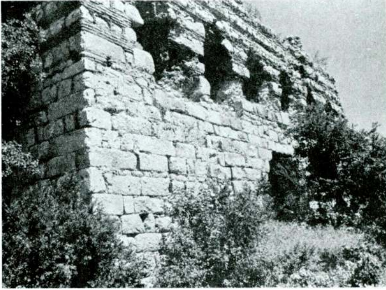
Res. 2 — Binanın kaide kısmı, solyukarı köşede tuğla tezyinatlı ufak saha görülmektedir.
