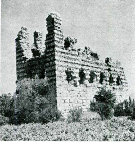
Res. 1 b — Kasaba tarafındaki cephe.
