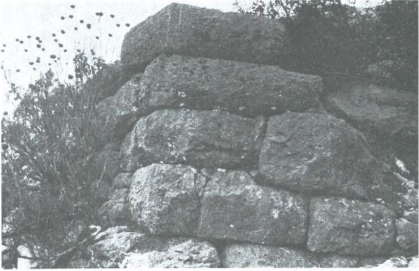
Res. 43 — Hisar içi tepesindeki duvarlardan bir kısım
