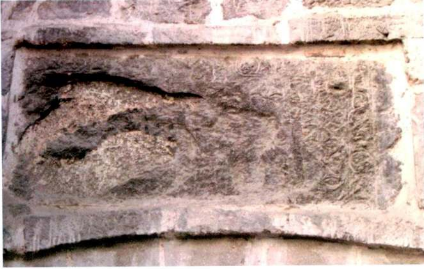
Resim 5. Doğu kapısı üzerindeki kitabe levhası
