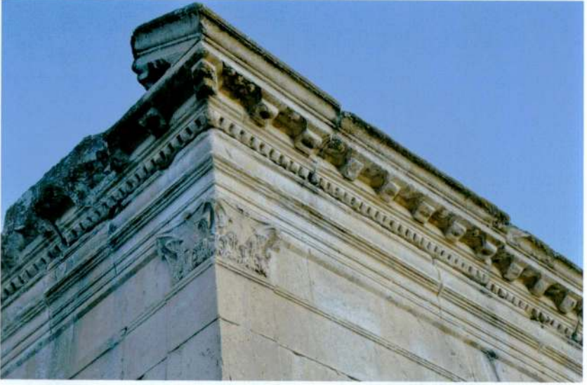
Resim 5 - Kuzey Köşe Detayı
