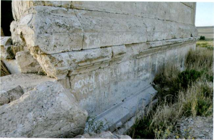
Resim 2 - Güneydoğu Cephesindeki Podyumun Görünümü
