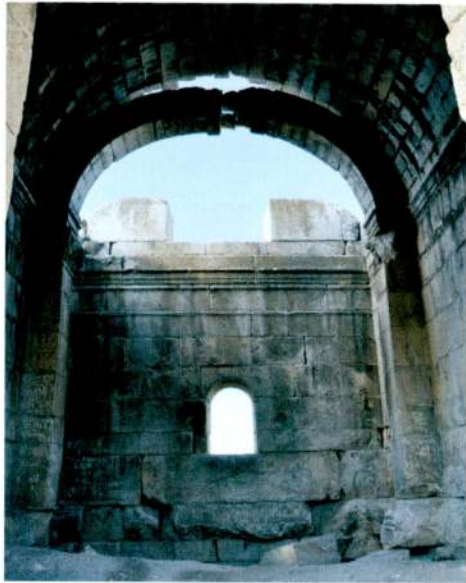
Resim 10 -Yapının Kuzeydoğu Duvarı İç Yüzü
