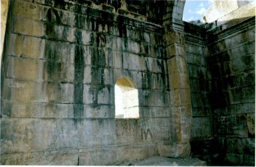
Resim 9 - Yapının Kuzeybatı Duvarı İç Yüzü
