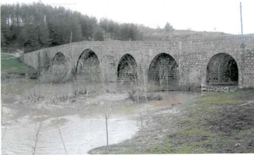
Resim 2 - Devegeçidi Köprüsü Genel Görünüşü
