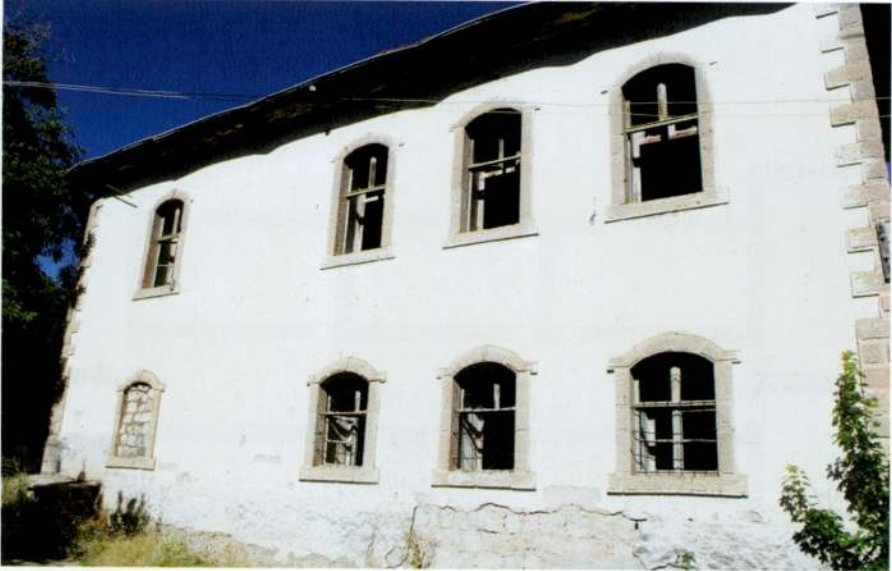
Resim 43 - Pazarören Köy Enstitüsü (Öğretmen Okulu) yan cepheden görünüşü
