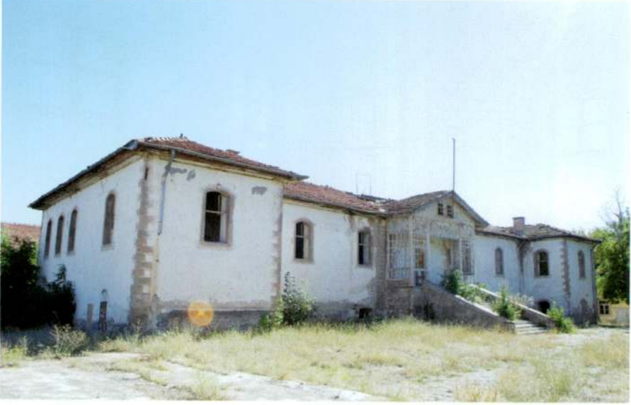
Resim 42 - Pazarören Köy Enstitüsü (Öğretmen Okulu) giriş cephesinden görünüşü.
