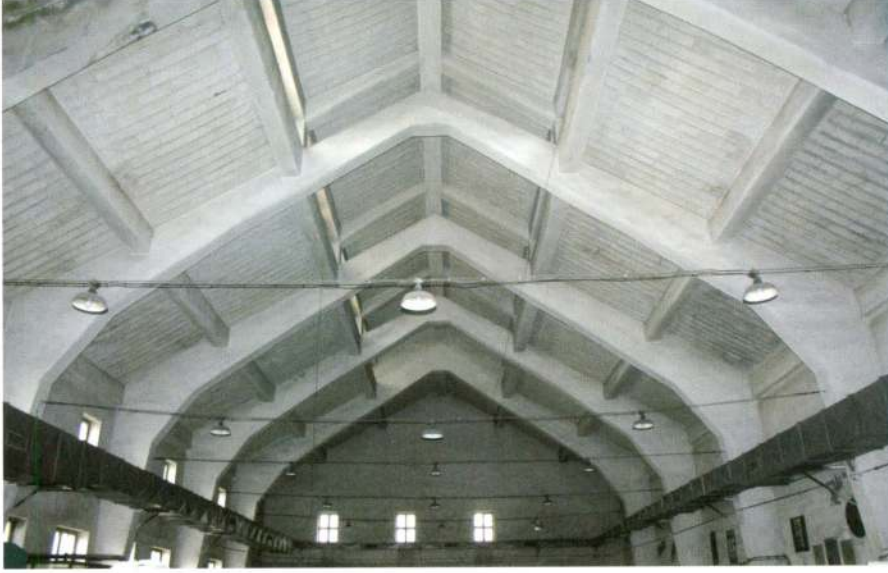
Resim 57 - Kayseri Erkek Sanat Okulu tesviye atölyesi üst örtü düzeninden görünüş.
