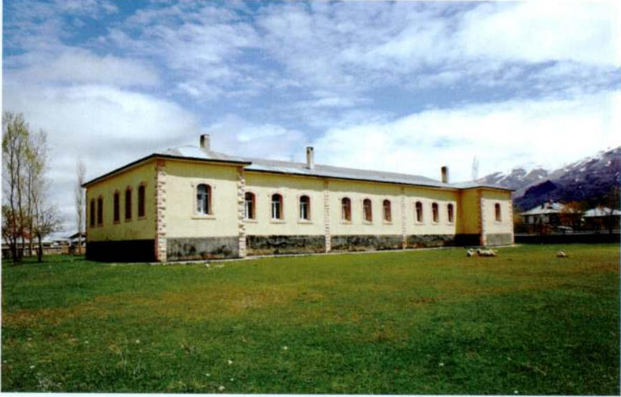
Resim 21 - Yeşilkent İlköğretim Okulunun güney ve batı cephelerden görünüşü.
