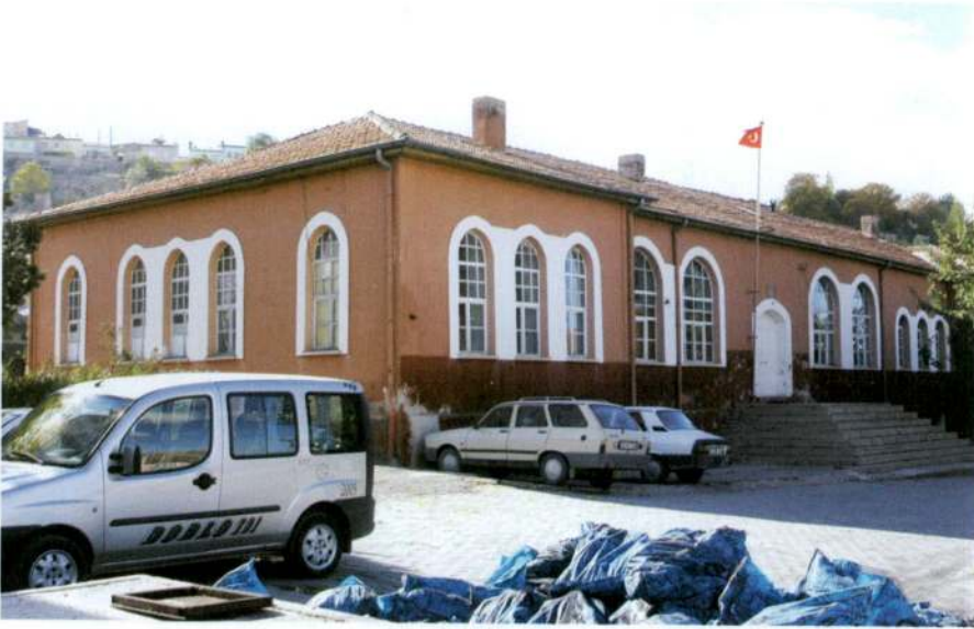
Resim 13 - Bünyan Sağlık Meslek Lisesinin kuzey ve doğu cephelerinden görünüşü.
