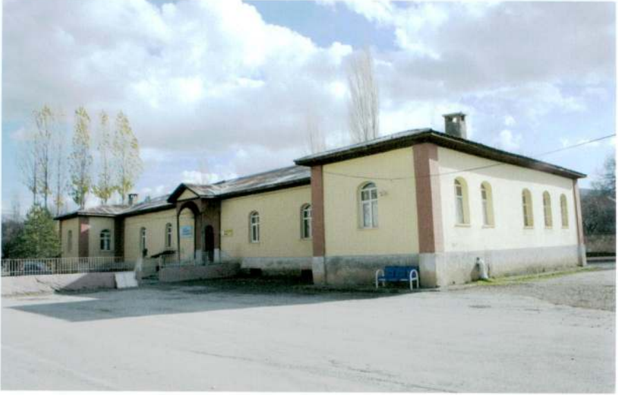
Resim 33 - Akkişla Cumhuriyet İlkokulu giriş (kuzey) cephesinden görünüş
