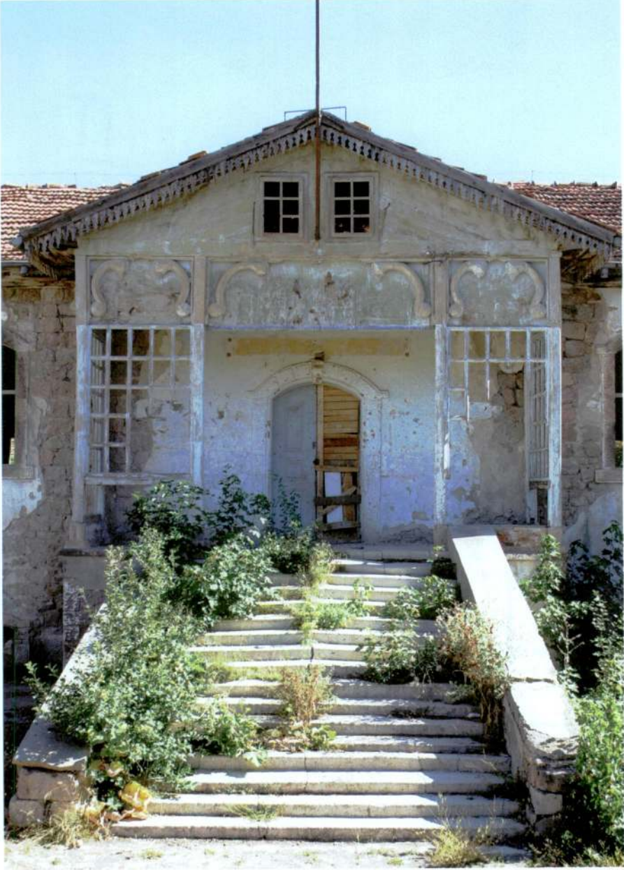
Resim 44 - Pazarören Köy Enstitüsü (Öğretmen Okulu) giriş revağı ve kapısından görünüşü.
