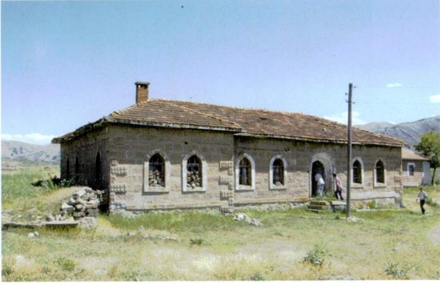
Resim 16 - Artmak Köyü İlkokulu kuzey ve batı cepheden genel görünüş.
