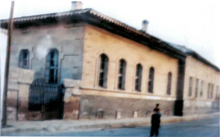
Resim 9 - İncesu Merzifonlu Kara Mustafa Paşa İlkokulunun yıkılmadan önceki durumu (İncesu Merzifonlu Kara Mustafa Paşa İlkokulu Arşivinden).
