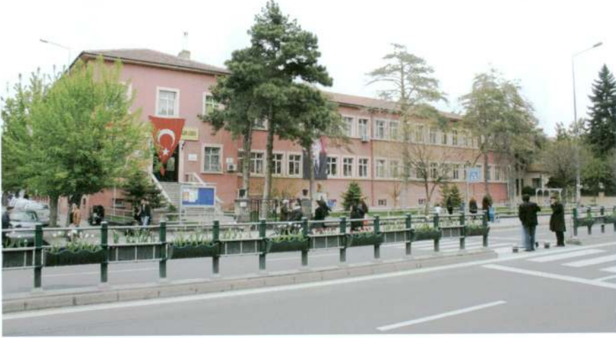
Resim 46 - Kayseri Kız Meslek Lisesi batı cepheden genel görünüşü.
