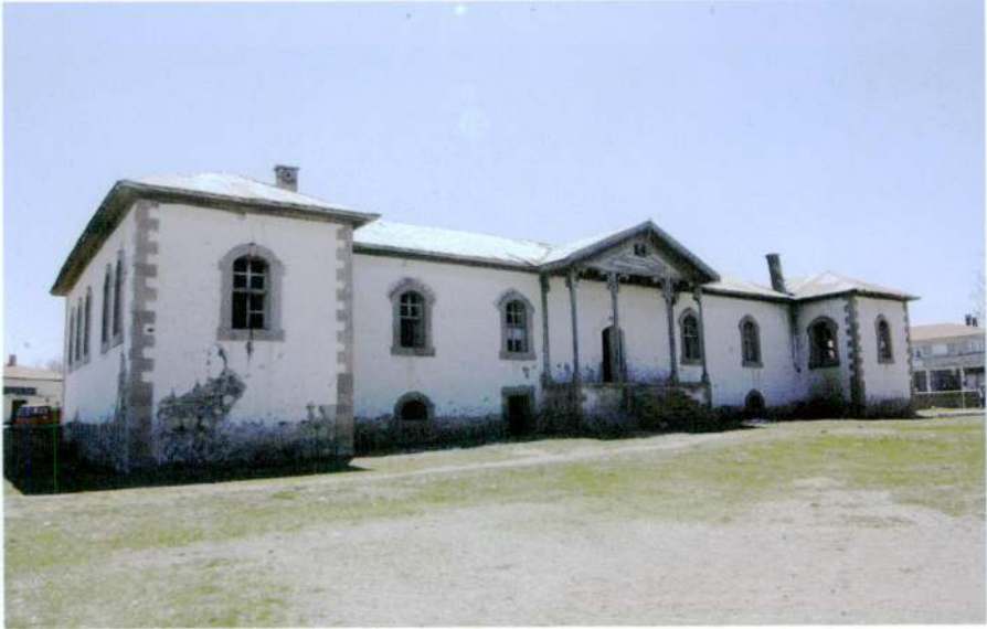
Resim 38 - Kaynar Kasabası İlkokulu giriş cephesinden (kuzey) görünüşü.
