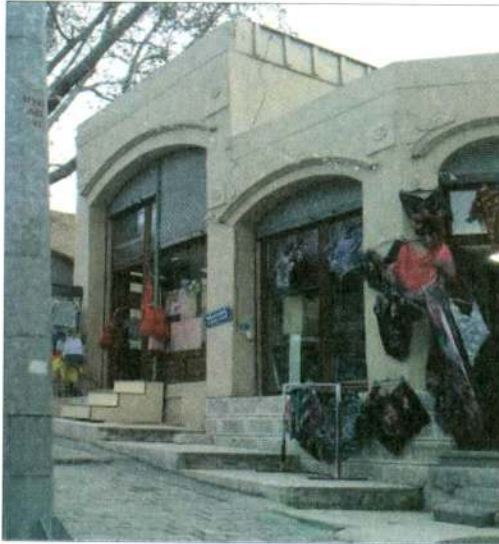
Resim 3. Eğime Dik Olarak Gelişen Yapı Yerleşim Şekli, 2013.
