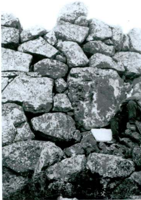
Resim 9: Karakale tahkimat duvarlarından ayrıntı.
