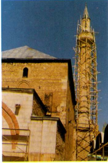
Resim 5 - Bor Sokullu Mehmet Paşa Camii, güneybatı taraftan görünüşü.
