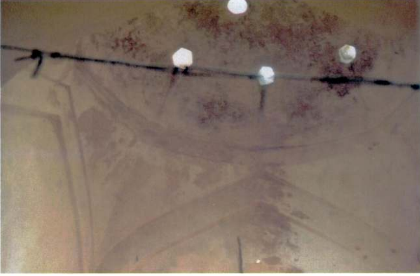
Resim 37 - Bor Sokullu Mehmet Paşa Hamamı, erkekler kısmındaki halvetin örtü sistemi.
