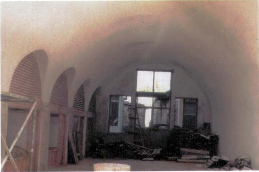
Resim 22 - Bor Sokullu Mehmet Paşa Arastası, iç mekândan görünüş.
