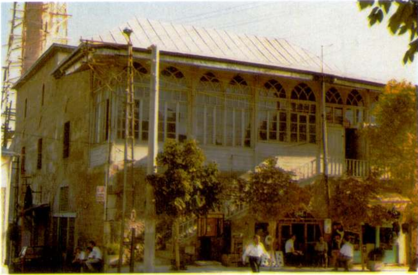
Resim 2 - Bor Sokullu Mehmet Paşa Camii, kuzey ve doğu taraftan görünüşü.
