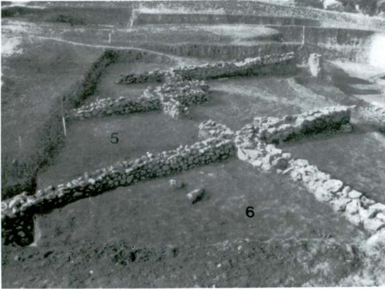
Levha 13/1 – İTÇ 2 yapı katının temel kalıntıları kuzeyden - 1996.
