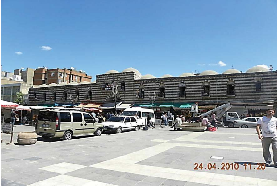
Foto. 8: Hasan Paşa Hamı Genel Görünüşü.
