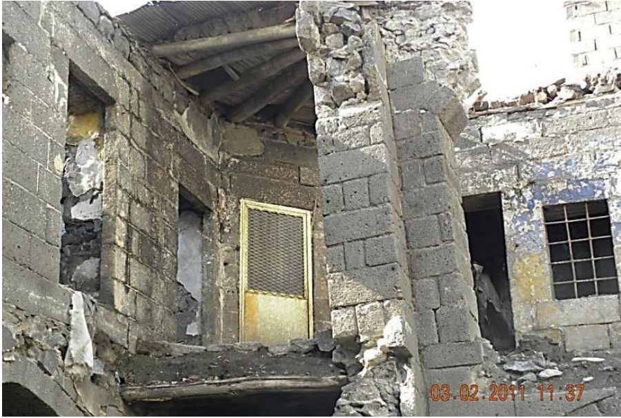
Foto. 18: Çifte Han Revak Örtü Sistemi Detayı.
