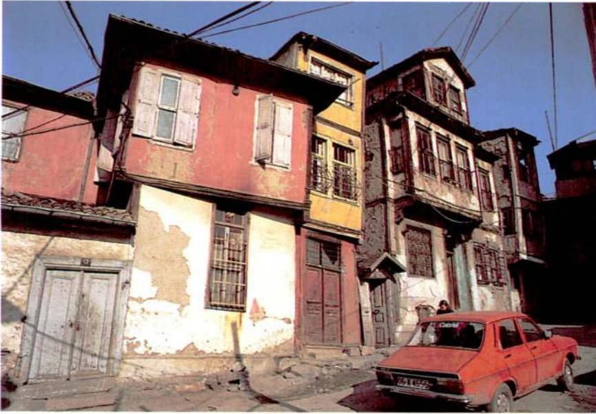
Res. 3 – Yahudi Mahallesi - Konutlar. The Jewish Quarter - Houses.
