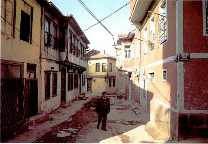
Res. 2 – Yahudi Mahallesi - Konutlardan genel görünüm. The general view of the houses.
