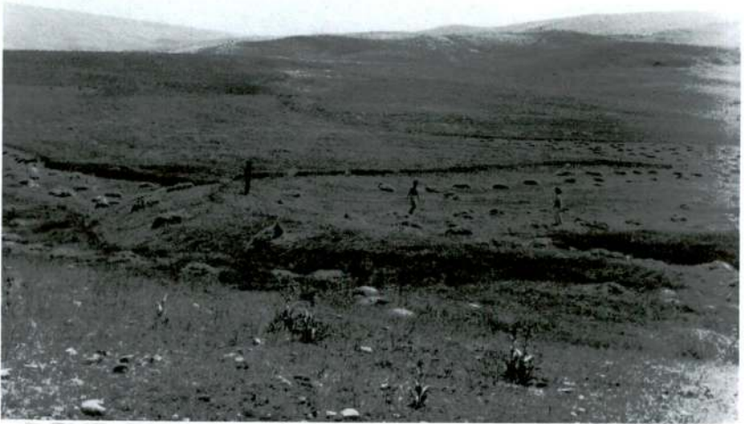
Resim 50 – Üzeri kalın bir toprak tabakası ile kapanan Reşan Baraj duvarı.
