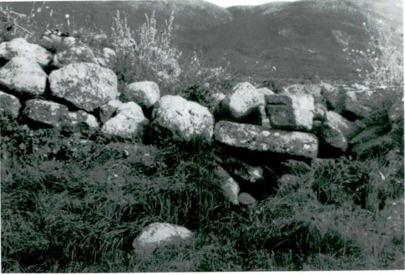
Resim 39 – Halk tarafından sökülen baraj duvarındaki su akıtma savağı, kuzeyden.
