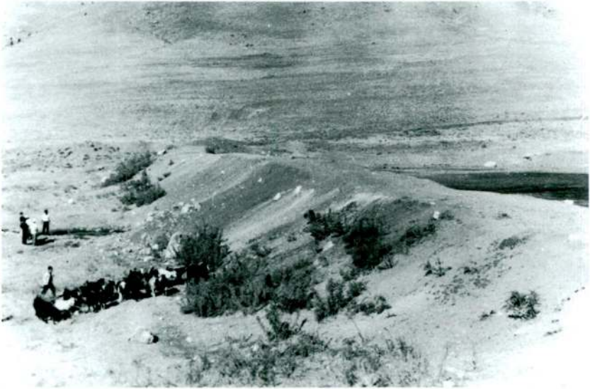
Resim 5 - Üzeri taş ve toprak ile kapatılan Yukarı Anzaf Baraj duvarının dış kısmı.
