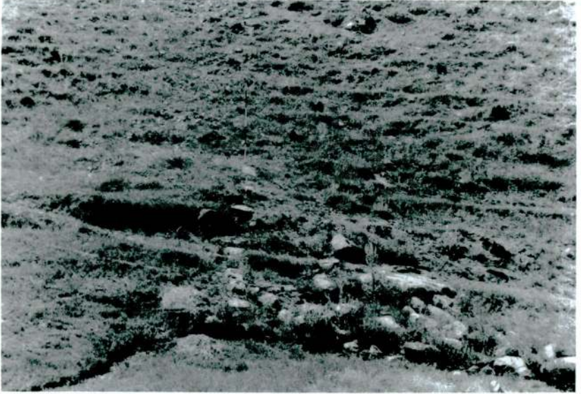
Resim 18 – Sular tarafından parçalanmış Arç Barajı'nın temel duvarları.
