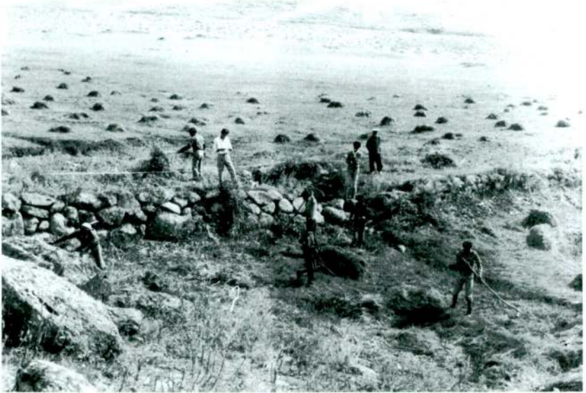
Resim 38 – Yukarı Argıt Baraj duvarının kuzeyden görünümü.
