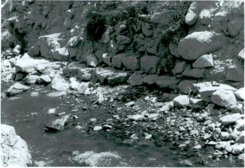
Resim 14: Baraj duvarının gneyinde su akıtma savađının getiđi temel kısmı.
