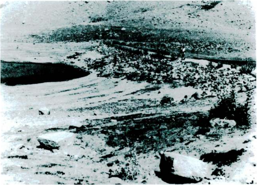
Resim 2 - Süphan Gölü'nün güney ucuna inşa edilen Yukarı Süphan Barajı.
