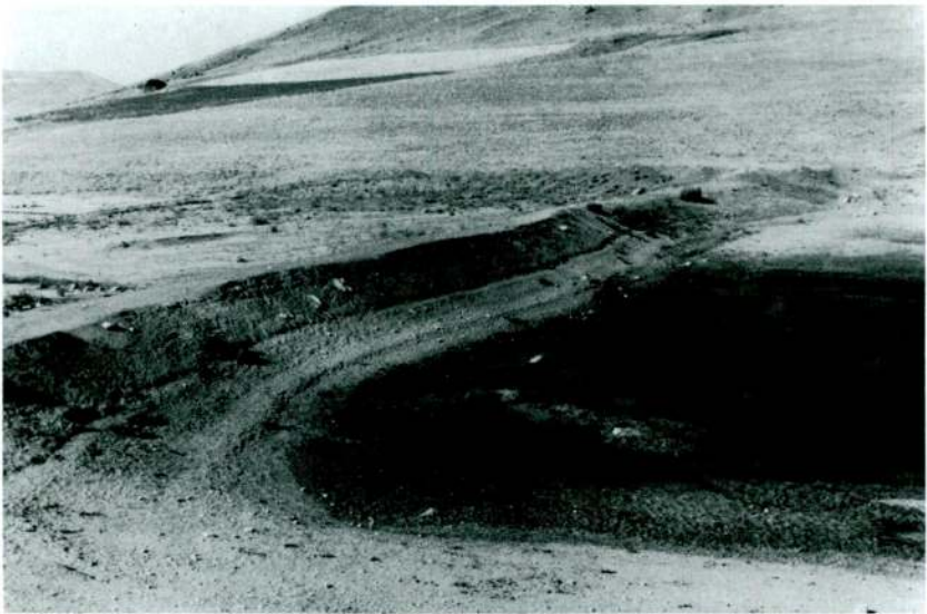
Resim 6 - Üzeri taş ve toprak ile kapatılan Yukarı Anzaf Baraj duvarının iç (güney) kısmı.
