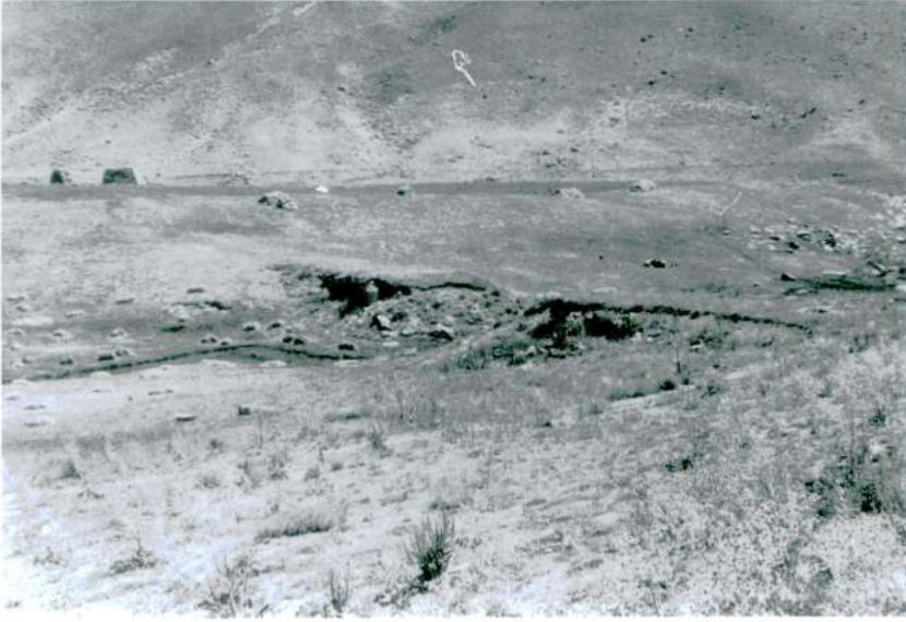
Resim 3 – Dar bir boğaza yapılan Aşağı Süphan Barajı.
