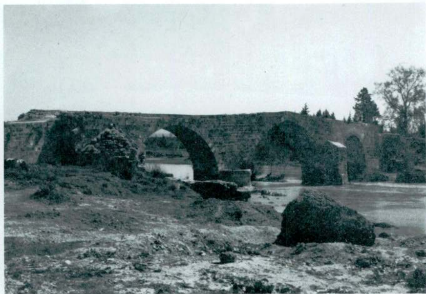
Fig. 20 — Köprüpazar (Belkıs) bridge.
