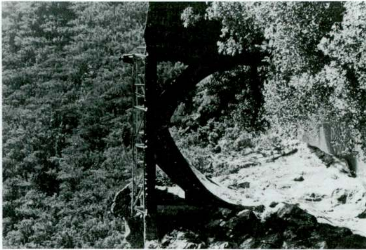
Resim 1 – Gündoğmuş "Kemer Köprü"
