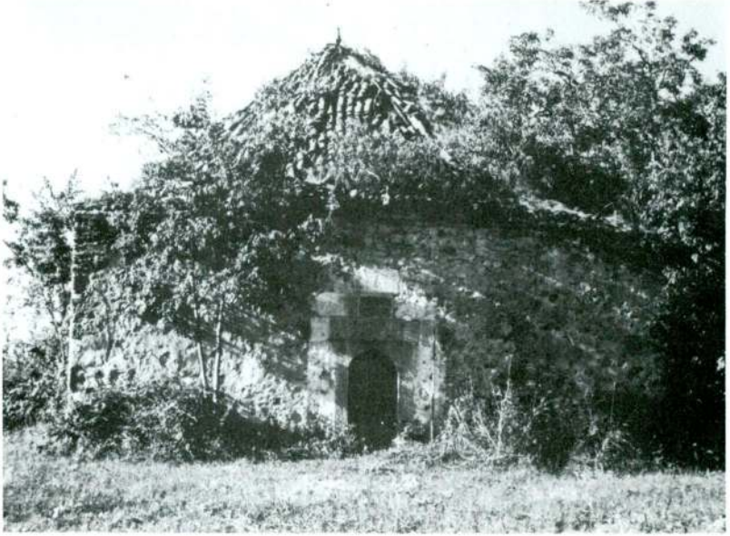
Res. 15 — Bafra, Türbe Köyü Emir Mirza Türbesi
