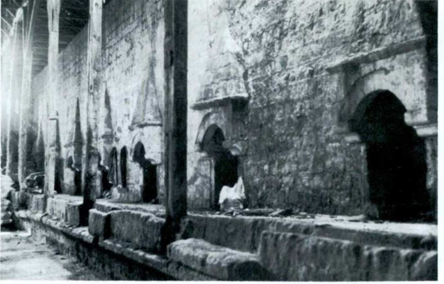
Res. 17 — Kapalı han kısmının iç görünüşü ocaklı seki.
