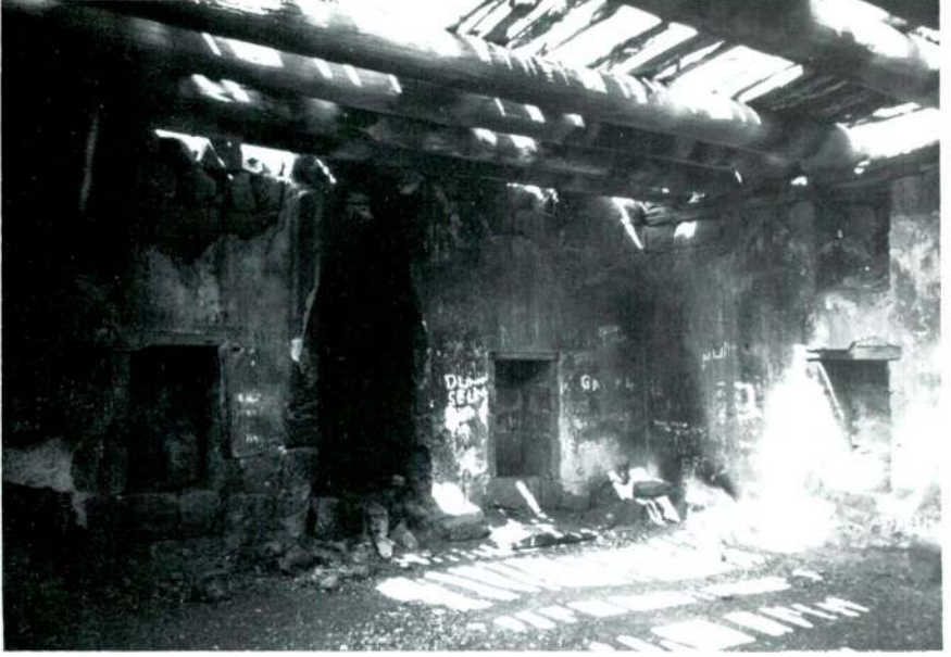
Resim 7 – Mutfađın üst örtüsü (içten).
