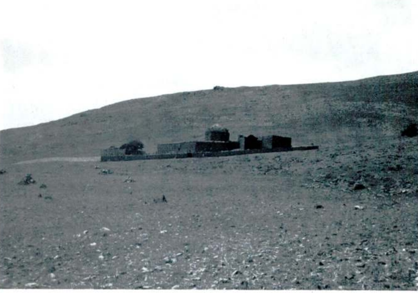
Resim 1 – Külliye'nin Havadan Köyü'nden görünüşü.
