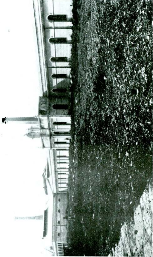
Abb. 11 Ansicht des 1883/85 neugebauten Feshane mit der grossen Shed-Halle rechts und der Maschinenanlage links (Archiv DAI Istanbul R 24 924)
