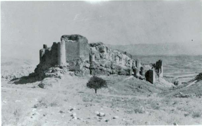
Res. 2 — Sivas Amerikan Kolejinin Yıkılmış olan Binası
