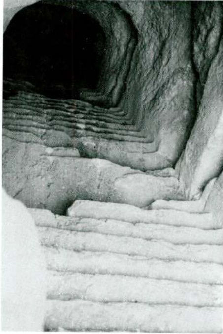
Abb. 17 — Treppentunnel B von Şirinlikale
