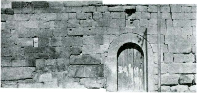
Rs. 7 -- Osmanlı devrinde eklenen diğer kapının ve duvar işçiliğinin farklı görünüşü.
