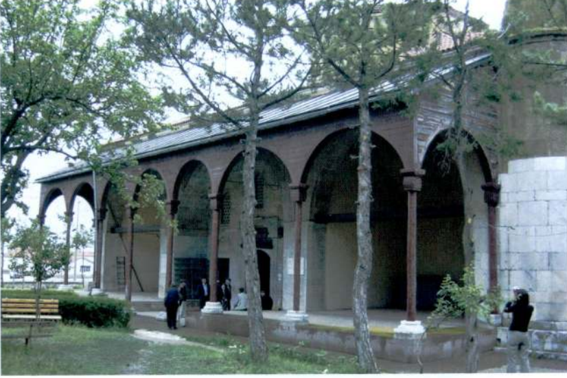
Resim 13: Eskişehir Han Hüseyin Paşa Camii- giriş cephesi.
