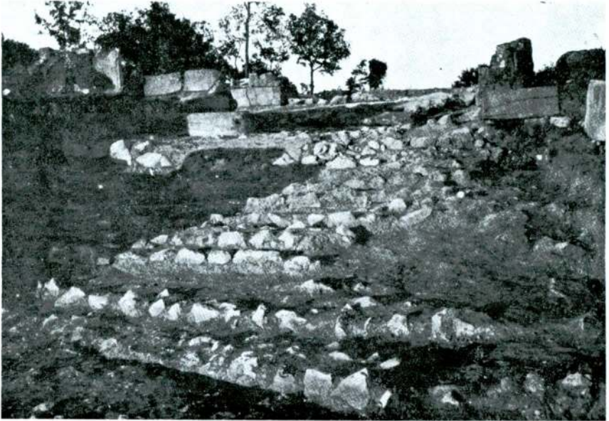
Res. 11 — Karatepe : Yukarı giriş binasındaki merdivenin güney-batıdan görünüşü. Fig. 11 — Karatepe : View of the angular stair-case from the SW.
