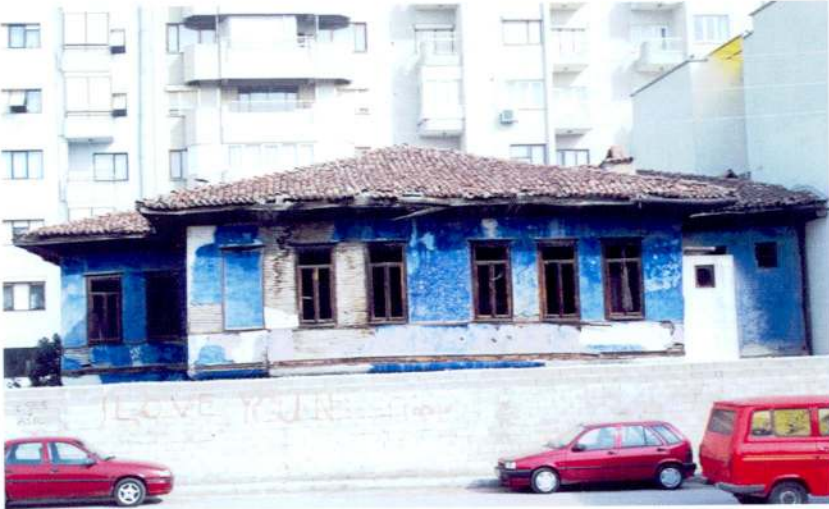
Resim 4: Konağın Arka Cephesi
