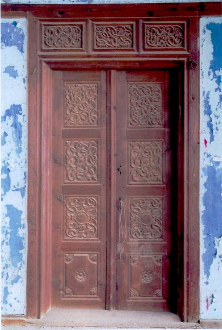
Resim 7: Üst Kat Kuzeybatı Oda Kapısı
