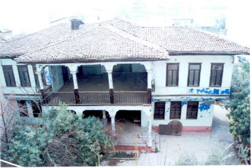
Resim 3: Konağın Ön Cephesi
