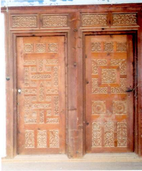
Resim 11: Üst Kat Güneybatı Oda Kapıları
