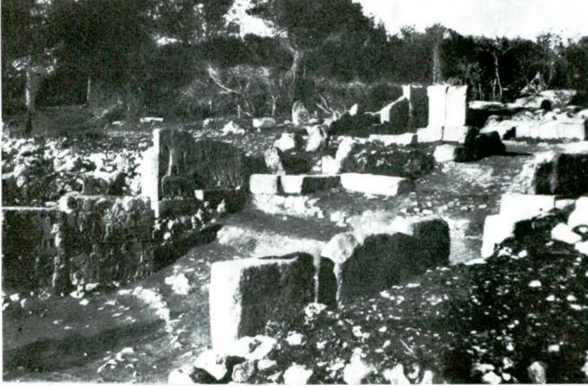
Res. 5 — Yukarı Kazı alanındaki giriş binası geçidinin güney-doğudan görünüşü.
