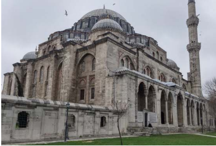
Şekil 16: Şehzade Camisi güneydoğu ve kuzeydoğu cepheleri (EMR Mimarlık).
