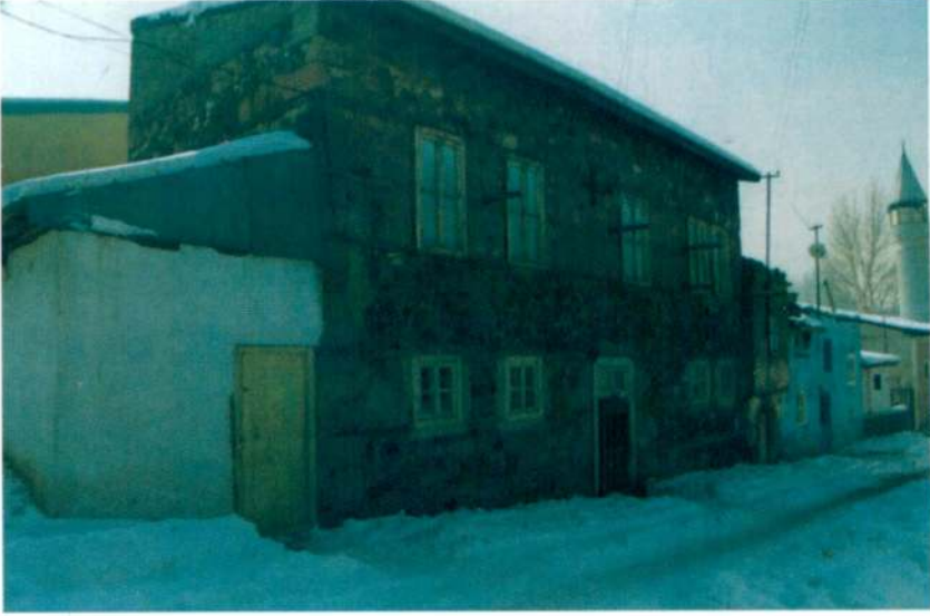
Resim 35 - 11 No'lu örneęe ait ön görünüş (Ketecioęlu evi)
