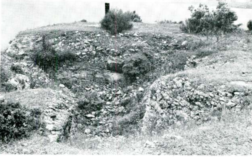
Res. 41 — Geblez Tepe üzerindeki Bizans sur duvarlarının kalıntıları.
