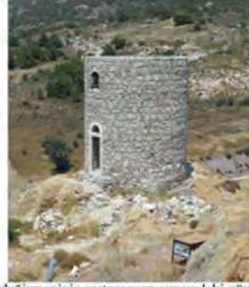
Yel değirmeninin restorasyon sırasındaki görünümü
